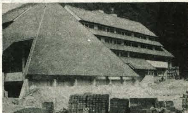
PRED ZIMO NOV HOTEL V GOZDU MARTULJKU — Petrol iz Ljubljane gradi v Gozdu Martuljku nov hotel B kategorije. Predvidajo, da bodo delavci Slovenijaceste tehnika gradbenega dela končali pred letošnjo zimo. Konec septembra naj bi bil po načrtu hotel odprt, vendar so se dela nekoliko zavlekla. V hotelu bo skupaj s starim delom 260 postelj, 300 restavracijskih sedežev, dve klubski sobi s po 80 sedeži, večnamenska dvorana z 200 sedeži in disko klub. Petrol namerava podreti še dotrajani mladinski dom in urediti okolico s teniškim igriščem. — Foto: D. Sedej
