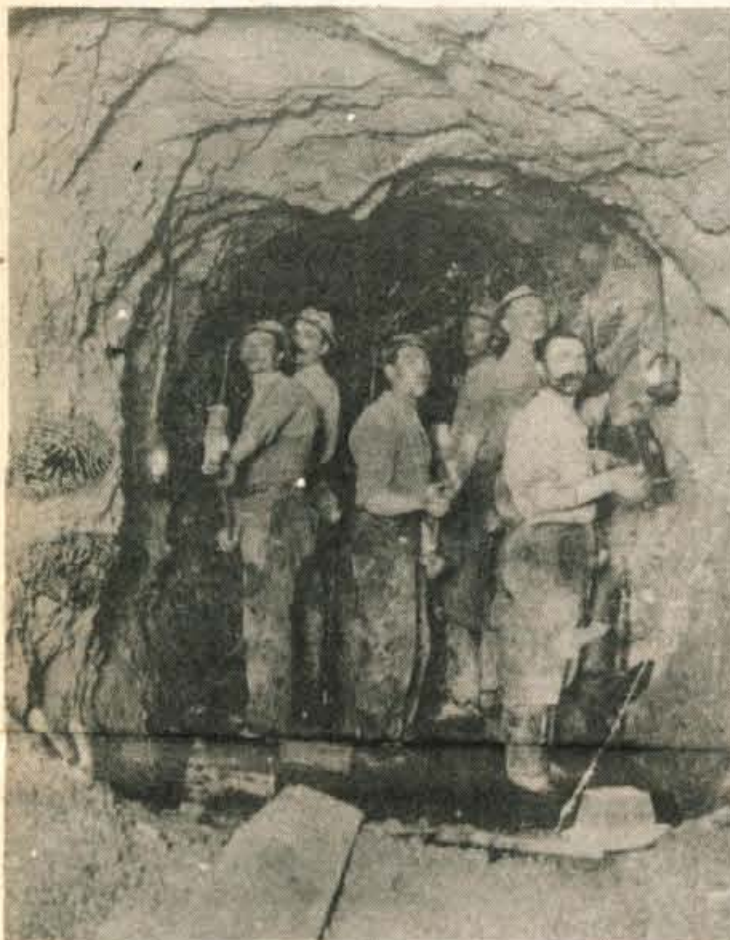
BOHINJSKI PREDOR — Leta 1901 so delavci s težkimi kladivi začeli tolči trdo skalo za tako imenovani bohinjski predor na železniški progi, ki je Jesenice povezala s Primorsko. Predor je bil končan leta 1906. Kljub hitremu razvoju železnic pa se je po Gorenjskem še dolgo časa slišal tudi postiljonov rog in vozarjev bič.
