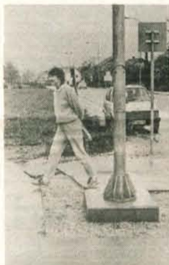
Nedokončano delo — Živila, ki so na Kokrici zgradila veliko, dobro založeno in obiskano samopostrežno trgovino, so pred meseci izpolnila tudi svoj malo pozabljeni dolg: uredila so dostop do trgovine z opozorilnimi svetlobnimi znaki in zebro, kot terjajo cestnoprometna pravila. A spet smola! Pika ni in še vedno manjka. — Foto: F. Perdan
