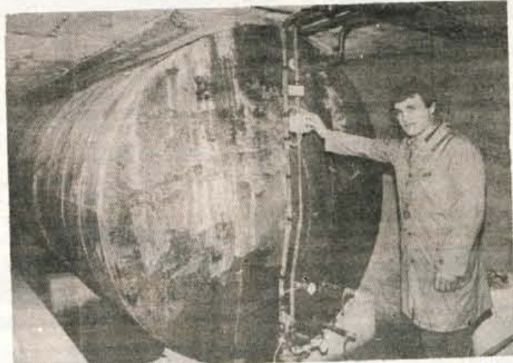
Za akumulacijo je uporabil staro bencinsko cisterno, ki bi jo sicer na odpadu razrezali v staro železo. Foto: F. Perdan
