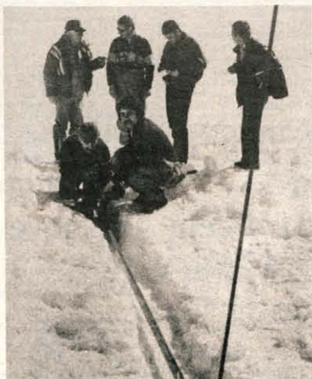
Posnetek je bil narejen v Planici v ponedeljek, ko so opravljali zadnja dela pri pripravi skakalnice. Vse je treba natančno izmeriti in skakalnico urediti po predpisih smučarske organizacije. Takole so merili pravilnost prehoda hrbta skakalnice v iztek. Izmere so morale biti do centimetra točne. — Foto: F. Perdan
