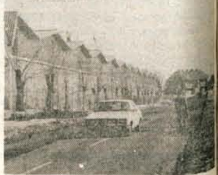
Letos je v programu rekonstrukcija Kidričeve ceste od železniške postaje do križišča pri Veletrgovini Loka.
