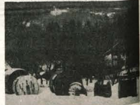
Kabli že čakajo, da bodo spomladi začeli
