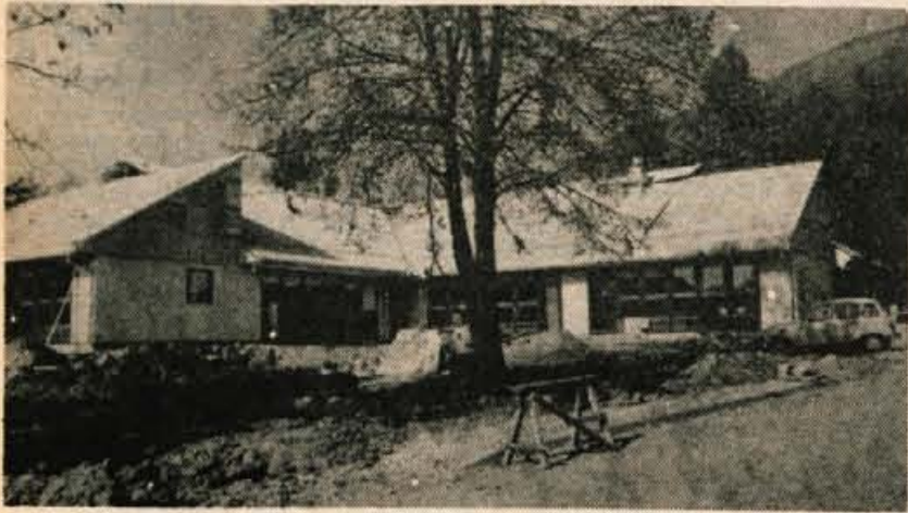
Golnik — Konec junija letos so na Golniku podrli pred 25 letj zgrajen montažni objekt, v katerem je bil vrtec za približno 100 otrok. Kmalu bo na istem mestu zgrajen nov montažni vrtec s šestimi oddelki za 120 otrok.
