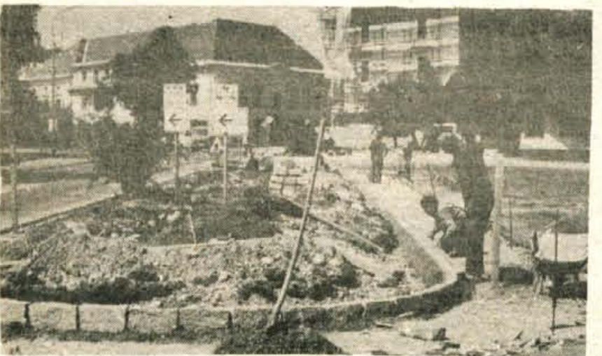
Radovljica, 29. avgusta — Da je bivanje v urejenem okolju prijetnejše, so spoznali tudi v Radovljici. Do konca oktobra bodo obnovili prek 400 metrov ceste od gasilnega doma do občine, mimo ekonomske šole in sodišča do banke, položili sto novih robnikov, zamenjali cestno razsvetlavo ter spravili vod nizke napetosti v zemljo. Za celotno obnovo so morali zbrati prek 60 milijonov dinarjev. Sredstva so prispevali: samoupravna interesna komunalna skupnost Radovljica, krajevna skupnost Radovljica in delovne organizacije s tega območja. Investitor je Komunalno gospodarstvo Radovljica, izvajalec del pa gradbeno podjetje Gorenc. Foto: F. Perdan, T. B.
