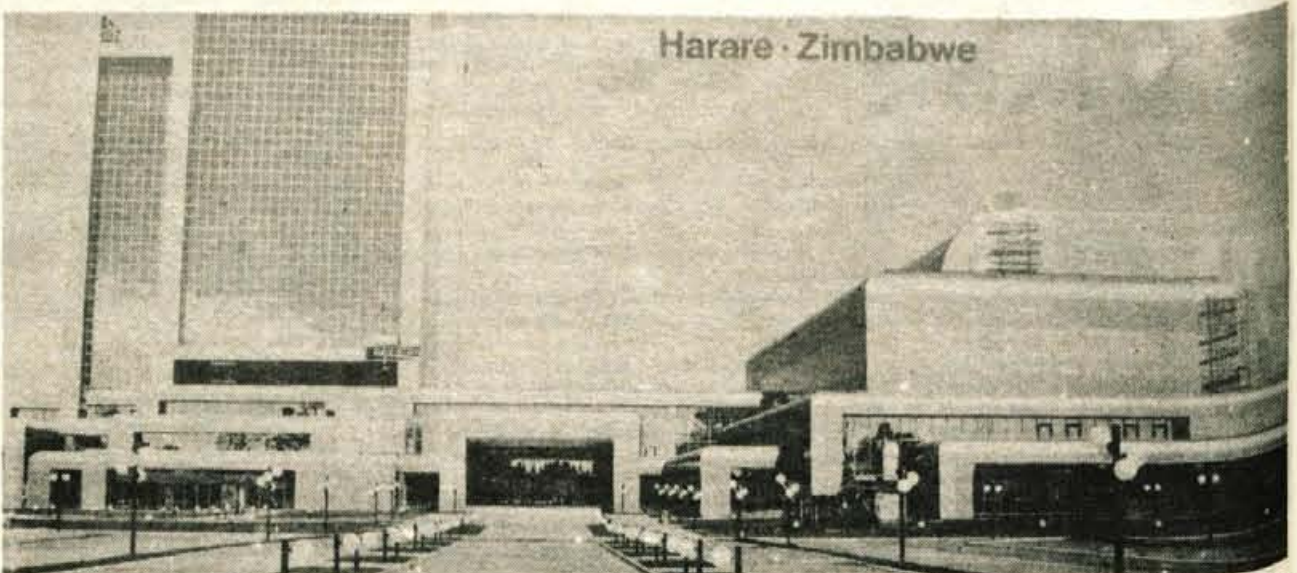
Konferenčno središče in hotel Cheraton Harare. Raztezata se na dobrih sedmih hektarjih površine. Graditi so začeli 22. novembra leta 1982, končali pa 29. julija lani. Gradnja je stala 65 milijonov dolarjev.
