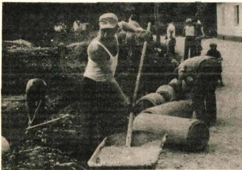
Cerklje — Pred dnevi so v krajevni skupnosti Cerklje s skupnimi močmi rešili težave, ki so jih povzročale meteorne vode v Ulici Ivana Hribarja. Delo so opravili prostovoljno, material in cevi pa je kupila krajevna skupnost. Že ta mesec nameravajo urediti avtobusno postajo, pripravljajo pa se tudi na gradnjo mrliških vežic. — J. Kuhar
