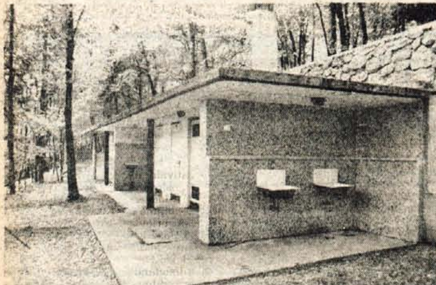
Skrb za urejen kamp — Prizadevni turistični delavci turističnega društva Dragočajna-Moše, ki ima okrog 100 članov, so v zadnjih letih že veliko naredili za urejenost in čim boljše počutje gostov v kampu v Dragočajni. Pred nedavnim so zgradili tudi oporni zid, kjer nameravajo urediti bališče in prostor za počitek ter razvedrilo gostov. Pod opornim zidom so zgradili tudi sanitarije. — A. Ž.
