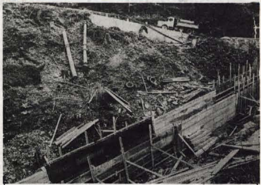
Škofja Loka — Dolgoletne napovedi, da bo cesta od Trebje do Zirov obnovljena, se končno uresničujejo. SGP Tehnik iz Škofje Loke gradi propust v Maharjevi grapi. Delo bodo končali v drugi polovici junija. — Foto: F. Perdan
