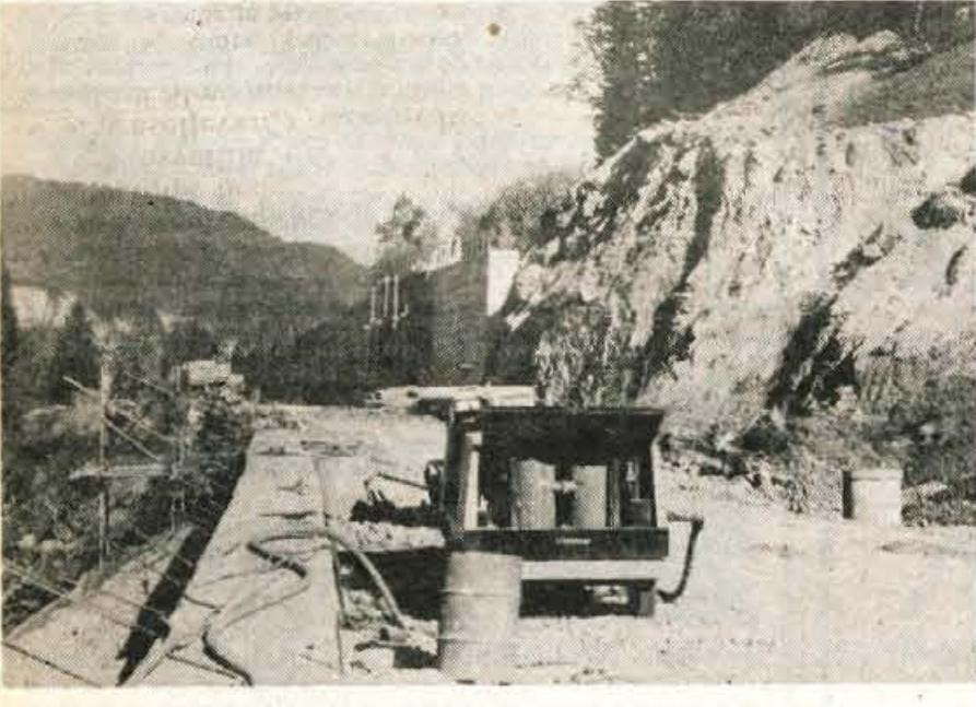
**Na najzahtevnejšem, 120 metrov dolgem odseku, kjer je bilo treba »presekati« aktivni zemeljski plaz in na zgornjem ter spodnjem delu ceste zgraditi pilotni steni, poteka še zadnji izkop. V pilote in steno je bilo vgrajenega 1800 kubičnih metrov betona. Na celotni trasi pa je bilo izkopanega in vgrajenega 140.000 kubičnih metrov materiala.**
