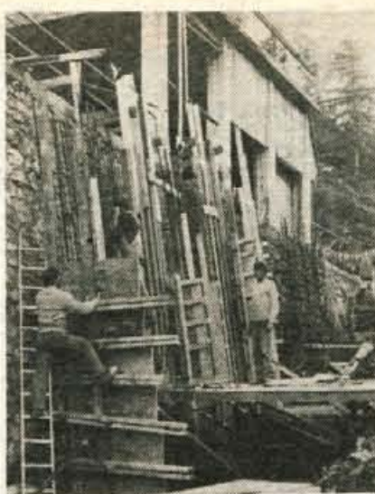
Nova zgornja postaja žižnice na Zelenici — Delavci splošnega gradbenega podjetja Tržič hite z granjo na Zelenici. Vremenske nepravilnosti in zob časa so namreč hudo načeli zgornjo postajo žižnice, zato so se žičničarji odločili zgraditi povsem novo, podprto z močnimi podpornimi stebri. Vreme gre graditeljem res na roko, vendar se zavedajo, da se zima bliža s hitrimi koraki, zato delajo vse sobote in vse nedelje. — Foto: D. Dolenc
