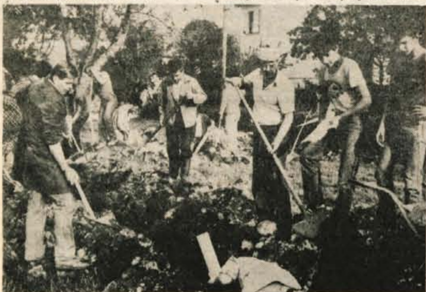
V soboto so »udarniki« iz Gorič, Tenetiš, Trstenika in z Golnika položili v zemljo 2300 metrov telefonskega kabla.
