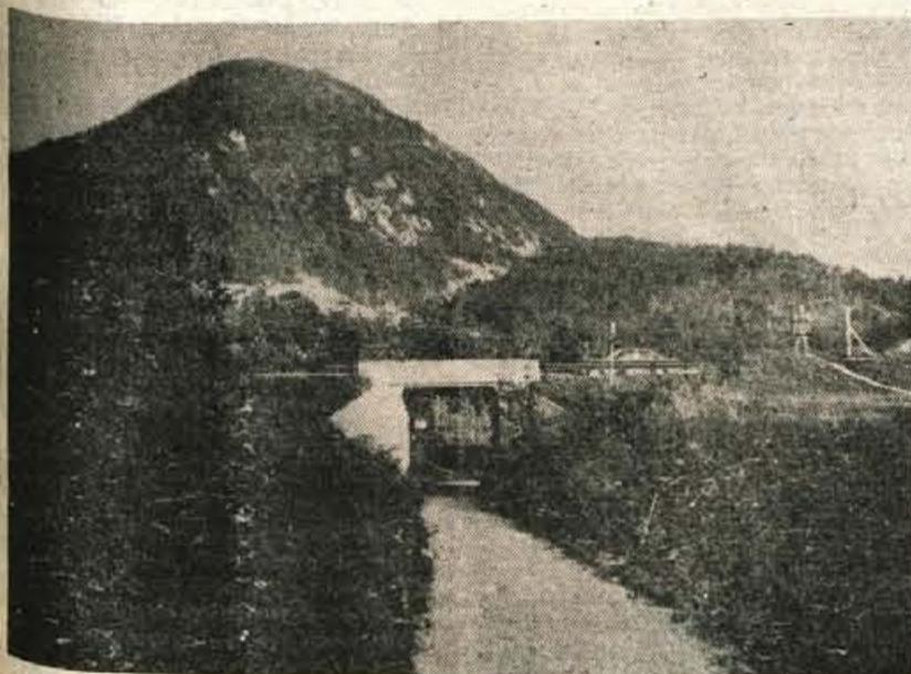
Podhod sameva — Čprav je v Bistrici urejen podhod za pešce, ga le malokdo uporablja. Zato bo ta del ceste dobil varovalno mrežno ograjo. — Foto: L. M.
