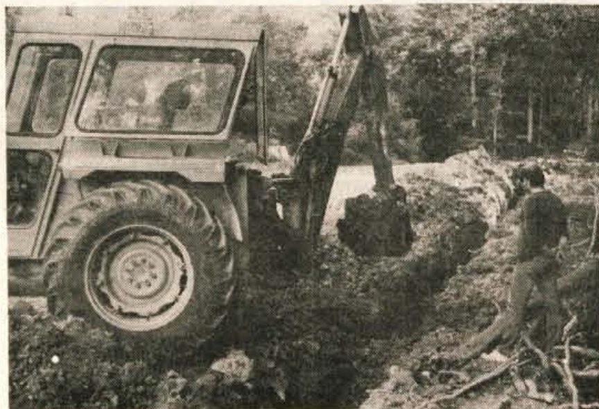
Brez strojev GG Kranj bi delo na vodovodu prepočasi napredovalo, z lopatami je mogoče le zasipavanje jarka. Ljudi pa je tukaj gori malo, zdaj je zbolel celo predsednik njihovega gradbenega odbora.
