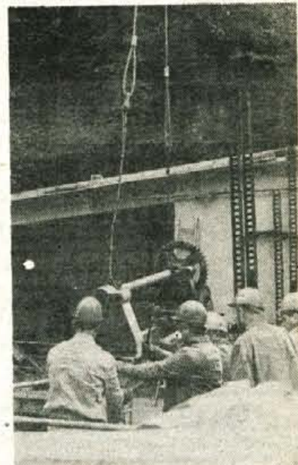
Zamenjava izpustnih zapornic v hidroelektrarni Kokra — Pretekli teden so Kranjčani s kokrškega mostu lahko opazovali prazno rečno strugo. V hidroelektrarni Kokra so delavci tozda Elektro Sava Kranj opravljali redni remont, pri katerem so s pomočjo 45-tonskega Gradsovega avtodvigala malo in veliko leseno izpustno zapornico zamenjali z železnima. Tehtali sta 4,6 tone, izdelani pa sta bili v domačih delavnicah. Hkrati je bil opravljen tudi redni letni remont strojnih naprav na hidroelektrarni. HE Kokra je leta 1898 zgradil Adolf Kreutzberger kot drugo kranjsko vodno elektrarno (prvo je leta 1893 Vinko Majdič). Z leti je bila predelana, povečana in spremenjena, leta 1971 pa delno avtomatizirana, tako da v njej delavec ni več stalno prisoten. V tridesetih letih (obdobje 1954—1984) je HE Kokra proizvedla 32.436 megawatnih ur električne energije. (-dp-). Foto: D. Papler
