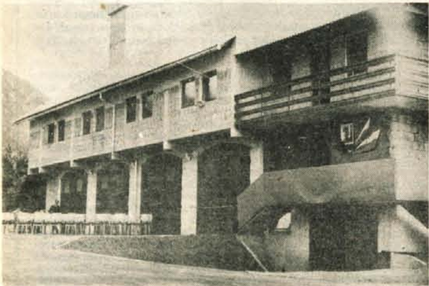
V Begunjah so gasilci postavili velik gasilski dom, v katerem bo tudi telefonska centrala in frizerski salon. — Foto: D. Sedej
