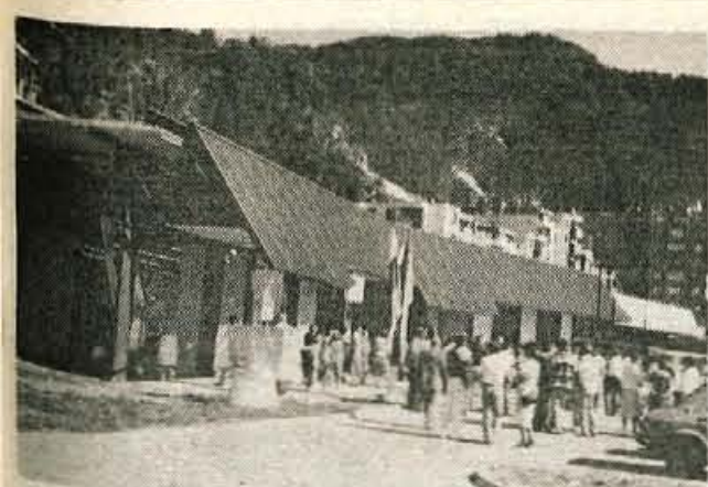
Novo zgradbo trgovskega centra na Deteljci sta skupno gradila Gradbincev in SGP Tržič. Rdečim streham na drugi strani ceste se je na tej pridružila temno rjava. Le Mercatorjeva streha iz gladke pločevine na sredini kazni videz. Veliko lepši izgled bi imele enotne strehe, ki bi že od daleč obljubljale ugleden trgovski center.
