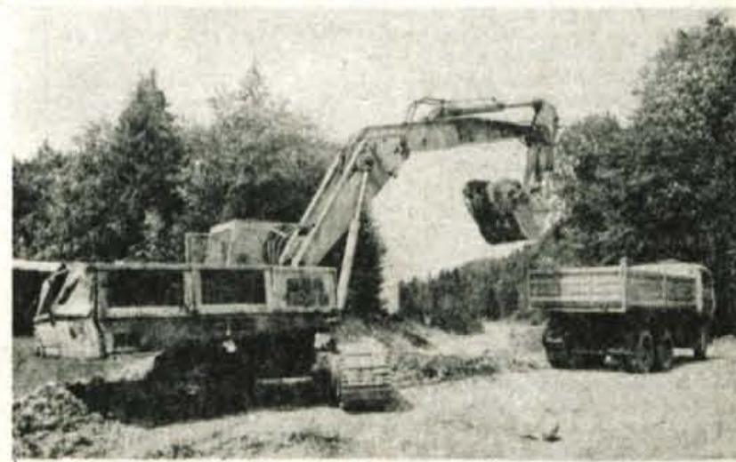
Dokler bo denar — Cestno podjetje iz Kranja hiti z deli pri gradnji Bohinjske ceste na območju Bohinjske Bele. Dobršen del denarja za izgradnjo te ceste, ki naj bi Bohinj predvsem bolj »odprla«, je prispevalo gospodarstvo radovljiške občine, del pa je primaknila tudi Skupnost za ceste Slovenije. Za zdaj pa kaže, da denarja ne bo dovolj, da bi cesto letos zgradili in odprli za promet. — A. Z.
