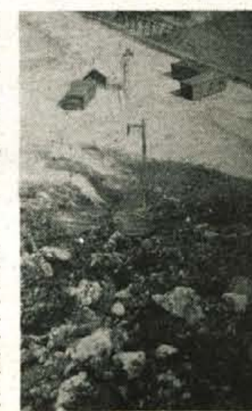
GLOBOKI KANALI IN SKALE — Ko se je zimska slava podkorenskega smučišča polegla in ko so zanj plačali sedem starih milijard, je začel tako opevani poligon temeljito propadati. Namesto poletne trave in ovac, ki naj bi teptale smučišče, voda spodkopuje teren, tako, da so v nevarnosti tudi stebri vlečnice, ki so jih lani celo s helikopterjem vozili na teren. — Foto: D. Sedej
