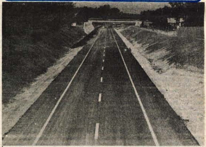
Začelo se je odštevavanje — Na 29 kilometrov dolgem odseku avtoceste Naklo—Ljubljana se je v torek, 21. maja, začelo odštevavanje pred svečanim trenutkom. Z delom je začela komisija za tehnični pregled avtoceste. Če bo vreme vsaj malo naklonjeno graditeljem, lahko pričakujemo, da bodo z deli končali nekako do sredine prihodnjega meseca. Potem pa bo le še stvar dogovora, kdaj bodo cesto svečano odprli za promet. (Več o tem na 16. strani) — A. Ž. — Foto: F. Perdan
