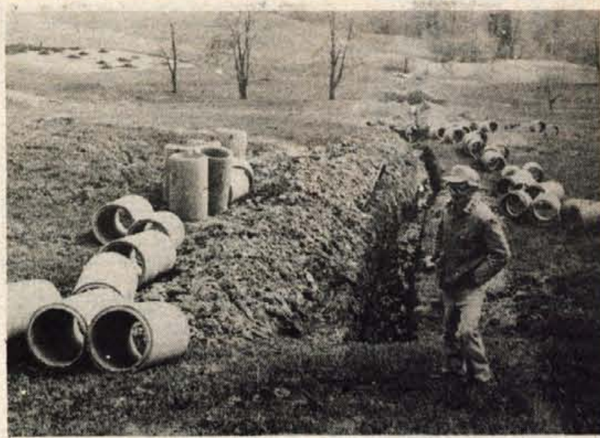
Ukročen hudournik — Ker je ob vsakem večjem nalivu voda drla čez travnik, s ceste pa odnašala pesek in ga nosila po travi, vaščani Leskovicice gradijo odvodni kanal, v katerega bodo ujeli hudourniško vodo. Foto: F. Perdan
