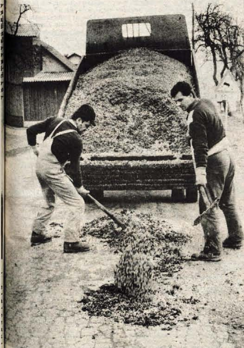
Prava pomlad na cestah se bo šele pokazala, čeprav so delavci Cestnega podjetja Kranj vso zimo na Gorenjskem (ob primernem vremenu in temperaturah) krpali udarne jame s tako imenovanim hladnim asfaltom — Foto: Perdan
