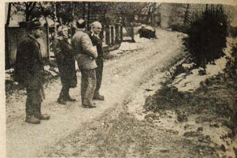
Tu naj bi se sedanja cesta z novozgrajenim odsekom preusmerila na gočila varnejše križišče s Cesto na Rupe. Prav tu pa priteče iz cesti tudi meteorna voda, ki potem teče deloma po cesti, deloma po zasutem jarku in razliva na zemljišča na obeh straneh. Krajani pravijo, da so cevi na tem odseku tudi preozke, zato se že pred tem precej vode razlije po dvoriščih in v neposredni bližini. Sicer pa ta voda menda ni zgolj moteča, marveč je v njej tudi še nekaj fekalij. V krajevni skupnosti menijo, da bi do končne uresničitve sedanjega idejnega projekta potrebna vlaganja ureditev. — Foto: F. Perdan
