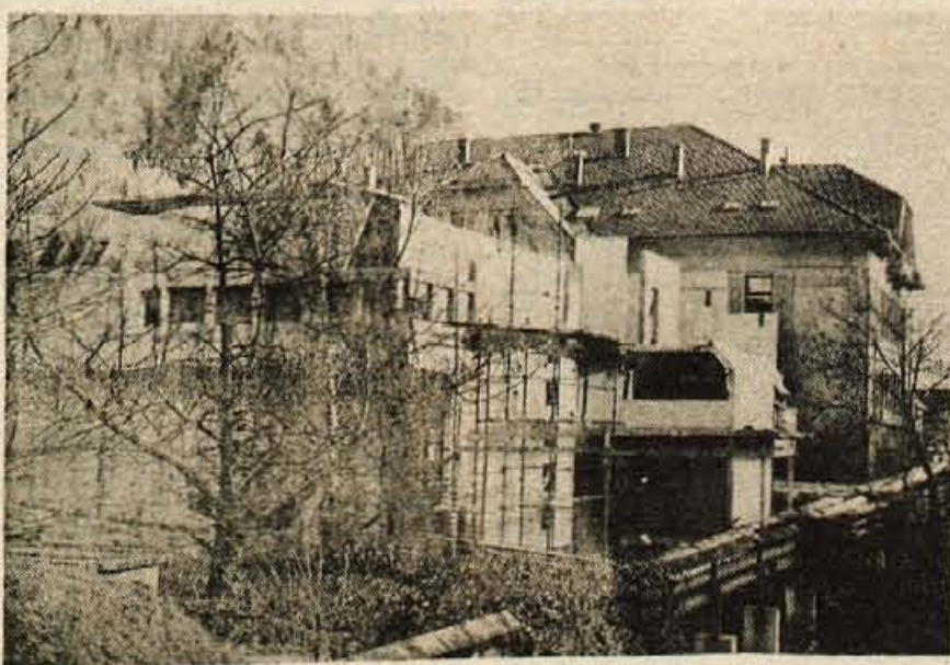
Kinodvorana na Jesenicah prihodnje leto — Ob stavbi gledališča na Jesenicah gradi Kinopodjetje Kranj novo kinodvorano ter več drugih prostorov za kulturno dejavnost jeseniške občine. Predračunska vrednost je znašala več kot 40 milijonov dinarjev, dvorano, ki je nadomestna gradnja za staro dvorano Radia Jesenice, ki jo bodo podrli, pa gradijo delavci jeseniškega Gradbinca. Samo dvorano bodo odprli naslednje leto, ostale prostore pa tedaj, ko bodo zagotovili dovolj denarja. (D. S.) — Foto: F. Perdan
