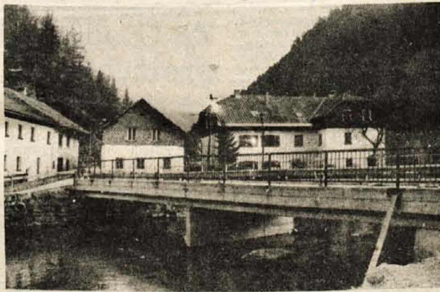
V teh dneh bodo na Plavžu odprli nov most. Prejšnji, lesen, je bil dotrajan. Izgradnja novega je veljala šest milijonov dinarjev
