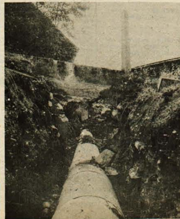
Pri izgradnji kanalizacije so krajanje naredili že prek 1000 prostovoljnih delovnih ur. Iz vsake hiše na Bregu ob Kokri...
