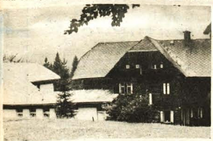
Večletna zapuščenost je krepko načela stari del stavbe Mladinskega doma v Bohinju, pa tudi novemu prizidanemu delu ni bilo prizanešeno.
