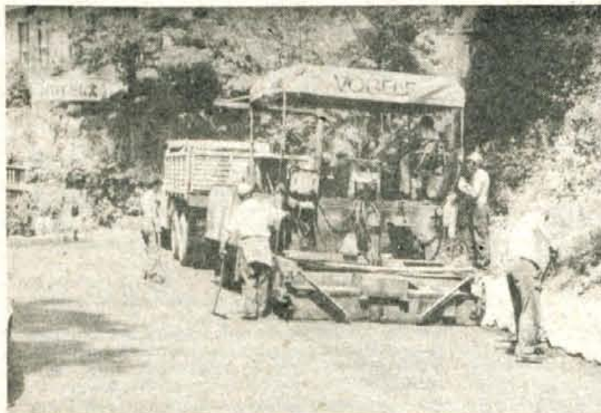
Asfalt na Jelenovem klancu — Cestno podjetje iz Kranja je včeraj končalo z ureditvenimi deli na Jelenovem klancu v Kranju. Granitne kocke so zaradi valovitega cestnišča zalili z asfaltom. Uredili pa so tudi odvodnjavanje in popravili robnike. Investitor del je bila Skupnost za ceste Slovenije. — A. Ž. — Foto: G. Šinik
