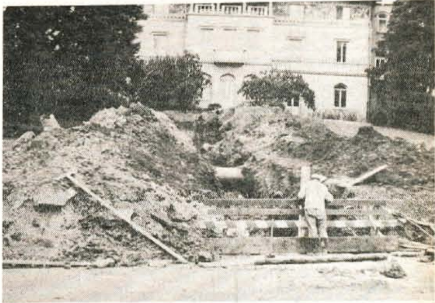
Potok Ušive bodo speljali v Blejsko jezero — Na Bledu te dni bližje hotela Park polagajo cevi, po katerih bodo v jezero speljali potok Ušive, ki izvira blizu ledene dvorane. Čista, celo malce topla voda ne bo več odtekala v kanalizacijo, temveč bo osvežila Blejsko jezero. Potočne vode niti ni tako malo, saj pretok potoka znaša 80 sekundnih litrov. Delo, ki ga vodi Franc Pelko, bodo končali do 1. maja. — M. V.
