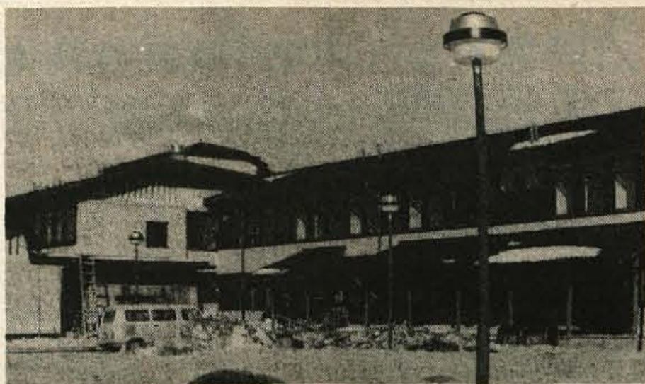
Kmalu nov zdravstveni dom — Graditev zdravstvenega doma Medvode poteka brez zastojev, tako da že vgrajujejo opremo. Z novim objektom, katerega naložbena vrednost je 167 milijonov, zgrajenim s samoprispevkom, bomo pridobili nove prostore za splošne ambulante, medicino dela, predšolski in šolski dispanzer, EKG, zobozdravstveno ambulanto za otroke in odrasle, prostore za zobni laboratorij, dispanzer za ženske, patronažno službo, fizioterapijo in skupne prostore. Pričakujejo, da ga bodo odprli že koncem prihodnjega meseca. —fr
