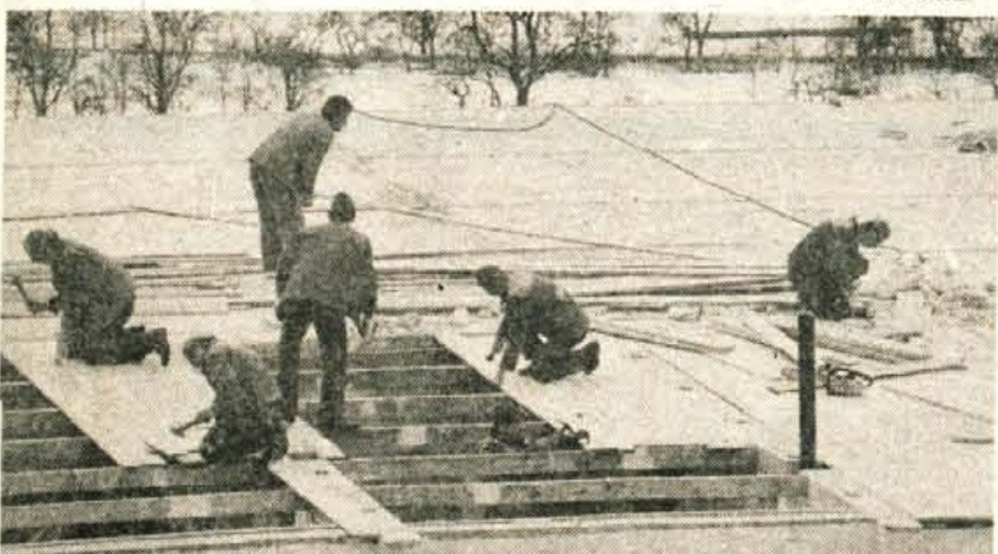
Begunje — Na strehi novega obrata plastike, ki ga je med vsemi objekti begunjskega Elana nedavno neurje najbolj poškodovalo, so člani kolektiva v nedeljski prostovoljni akciji odstranili poškodovano kritino. Zatem so delavci SGP Grosuplje, ki je halo gradilo, zasilno pokrili stavbo, da je v njej spet možna proizvodnja. Preden bodo na stavbo postavili novo streho, bodo izbrali proti neurju bolj odporno kritino. (S) — Foto: S. Saje
