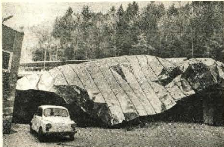
Odtrgano pločevinasto ostrešje s prodajalne Zarje na Jesenicah je veter odpihnil kot lahen list papirja.
