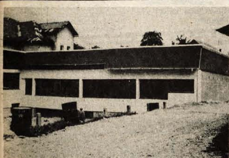
Prizidek osnovne šole na Koroški Beli — Z denarjem drugega samoprispevka so v jeseniški občini letos dodgradili prizidek k osnovni šoli Karavanških kurirjev na Koroški Beli. V njem so zaklonišča, garderobe, skladišče, sanitarije, kuhinja in jedilnica. Prilčno grajeni prizidek bo povezoval staro šolo z načrtovanim trinadstropnim šolskim splotjem, v katerem bo 14 učilnic — Foto: C. Zaplotnik
