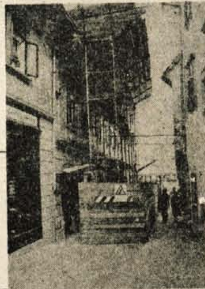
Škofja Loka — Na škofjeleškem Mestnem trgu so v teh dneh, sredi turistične sezone, tudi sredi obnovitvenih del. Prejšni teden so popravljali stopnice, ves čas pa potekajo tudi obnovitvena dela fasad in vzdrževalna dela hiš. Je to pravi ali pa morda skrajni čas? V. Primožič, Foto: I. Kokalj
