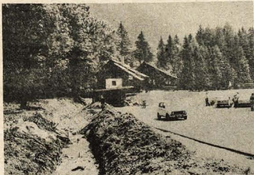
Ukročena Jezernica pri izlivu v jezero in iz jezera ne bo več poplavljala in povzročala škode. Odvodnjavanje bodo uredili tudi ob cesti Kazina — Mali vrh in zavarovali obrežje pod Kazino. Problema hudournikov oziroma voda na Jezerskem pa se namerava v prihodnjem srednjeročnem obdobju celovito lotiti Območna vodna skupnost Kranj, ki je za to že naročila načrte.
