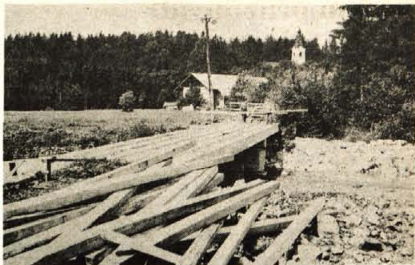
Breg ob Kokri — Delavci Vodnogospodarskega podjetja iz Kranja so 20. junija pričeli graditi 34 metrov dolg in pet metrov širok betonski most čez Kokro, ki bo povezoval vasi Tupaliče in Breg. Most bo zanesljivo nared do kranjskega občinskega praznika, 1. avgusta. Veljal pa naj bi 3,5 milijone dinarjev. — Foto: C. Zaplotnik
