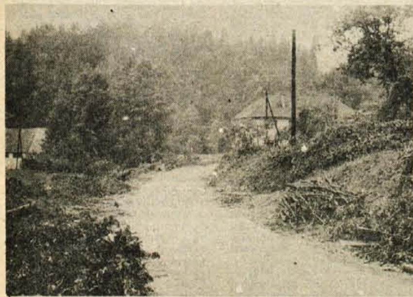
Minuli teden so lastniki na ureditveno najtežjem odseku ceste v Besnici začeli sekati in pospravljati les ter čistiti bregove.
