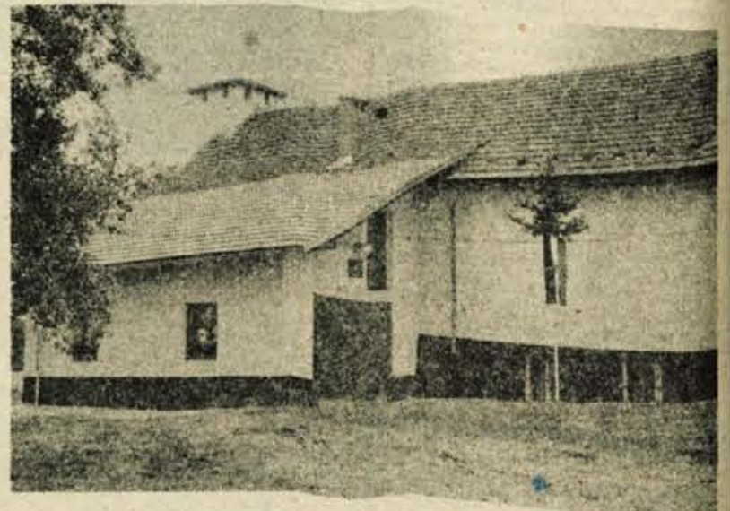
V nedeljo popoldne so v Besnici svečano odprli prizidek k domu družbenih organizacij, v katerem je gasilska garaža in orodjarna. Zgradili so ga s prostovoljnimi delom. — Foto: F. Perdan
