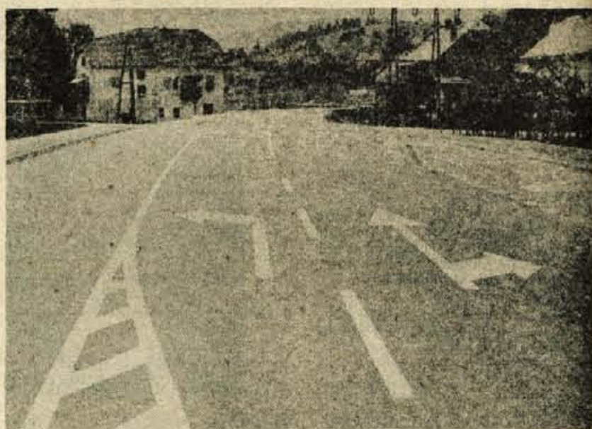
Poljane — Urnska cesta, ki zaradi pomanjkanja denarja zelo počasi napreduje od Zminca proti Gorenji vasi, je sedaj zgrajena do Kovačtje v Poljanah. Pred nekaj dnevi so jo odprli za promet in s tem se vozniki izognjejo ozkemu in nevarnemu delu skozi vas. Foto: F. Perdan
