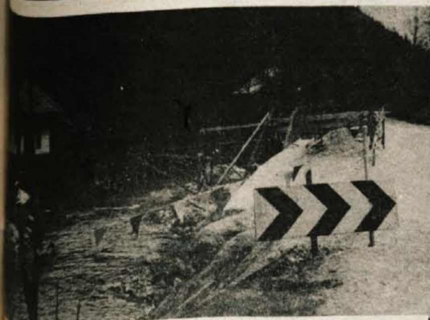
Najbolj kritična točka na cesti od Radovljice do Kroke je sedaj venčarje odpravljena, saj so naredili betonsko zaščito, da voda ne more več spodkopavati ceste in delati škode. — Foto: F. Debeljak
