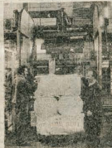
Na novo proizvodno halo, izzemalni stroj in avtomatski nakladalnik bal, ki so jih dobili lani, so delavci tovarne celuloze Obir še posebej ponosni. — Vse slike: F. Perdan
