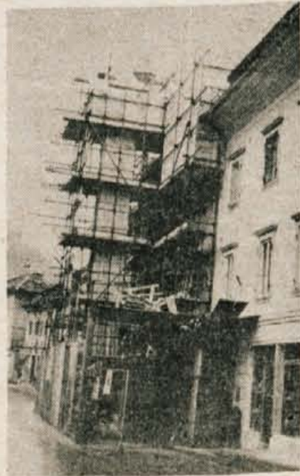
Tržič — V okviru programa revitalizacije starega mestnega jedra so se Tržičani lotili prenove Koželjeve hiše na Trgu svobode 11. V njej bodo predvidoma do občinskega praznika pridobili šest sodobnih stanovanj. — Foto: H. J.
