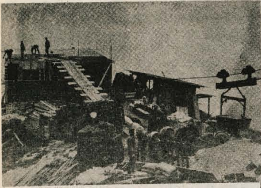
Med izgradnjo koč na Golici
