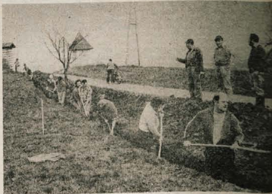
Pripravljalnih del za izgradnjo mrliških vežic se je na prostovoljni delovni akciji pred dnevi udeležilo 45 krajanov. — Foto: F. Perdan
