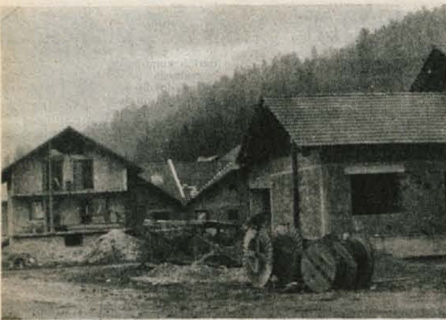
Posavec — V novem naselju Posavca gradijo 32 stanovanjskih hiš. Pred kratkim so delavci Elektro Kranj položili kabel za električne priključke in vgradili priključne nizkonapetostne omariče, vzporedno s tem pa je bil položen tudi kabel za javno razsvetljavo, za kar je sredstva prispevala krajevna skupnost Ljubno. V prihodnjem letu pa bodo postavili svetilke v ulicah komunalno urejenega naselja. D. Papler
