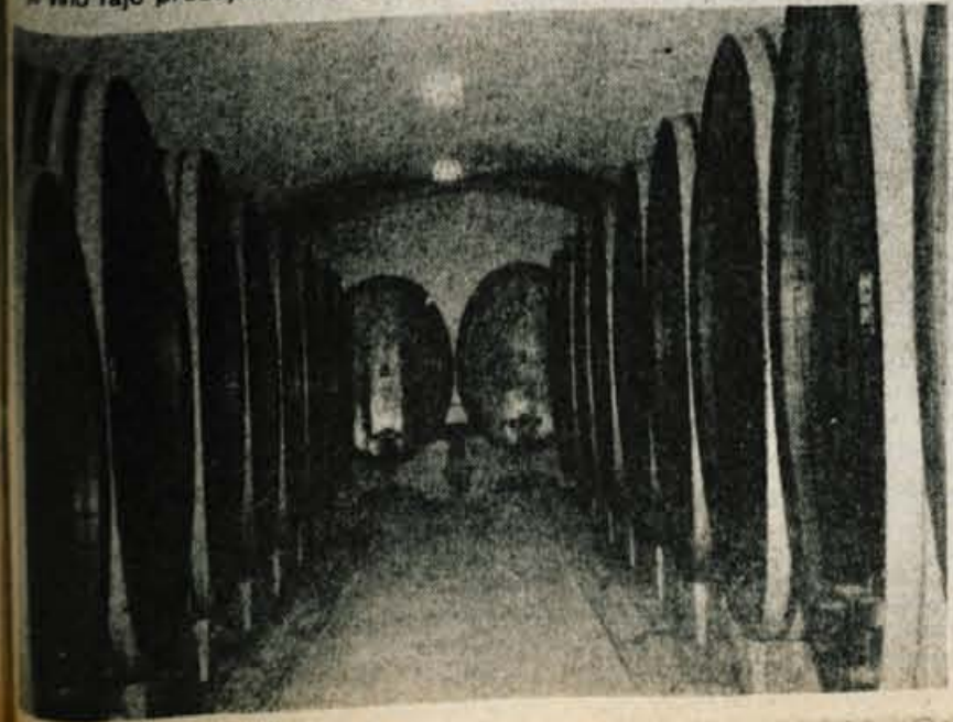
Nadzemni del vinske kleti na Dobrovem.
