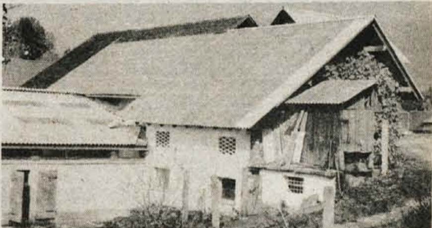
Lojze in Drago Zaplotnik sta sušilnico na segret zrak postavila na starem seniku, kar je povečalo stroške. Na sliki: svetli del strehe je kolektor, zbiralec sončne energije. — Foto: C. Z.
