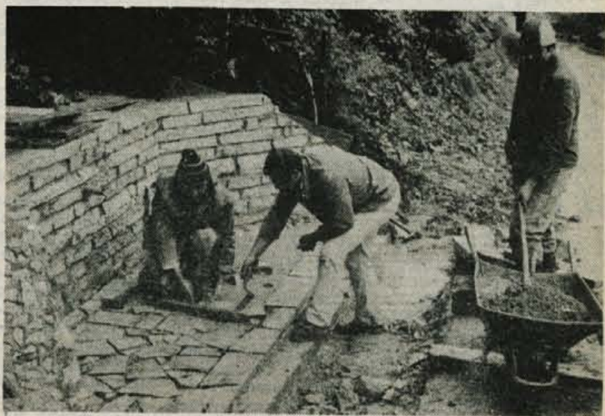
Oporni zid in zajetje studenca — Pred rekonstrukcijo Delavske ceste v Kranju je bilo ob vznožju pobočja Šmarjetne gore korito s pitno vodo. Ob rekonstrukciji pa so na studenec nekako pozabili in zato je voda potem ubirala svojo pot in posebno ob nalivih povzročala tudi škodo. V krajevni skupnosti Gorenja Sava so se zato odločili, da studenec ponovno zajezijo in speljejo v korito ter uredijo oporni zid. Mimoidoči se bodo tako lahko spet odžejali z mrzlo studenčnico, po potrebi pa bo voda na voljo tudi za druge namene. Denar je zagotovila krajevna skupnost, nekaj pa krajani s samopriskom. Dela izvaja zasebnik Silvester Vindiš s svojo delovno ekipo. Ureditev bo veljala okrog 100.000 dinarjev — A. Ž. Foto: F. Perdan
