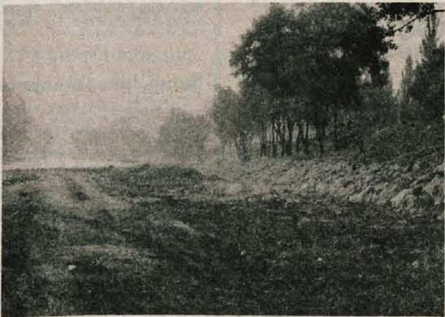
Rekonstrukcija ceste Iskra – Planika – Splošna vodna skupnost že nekaj časa ureja desni breg Save od Iskre proti Planiki v Kranju. Ureditev obrežja je potrebna zaradi rekonstrukcije ceste od Iskre do Planike. Cesta bo potekala po terenu, kjer so zdaj parkirani avtomobili, ob njej pa bodo uredili parkirne prostore. Rekonstrukcija financirajo delovne organizacije Iskra, Planika, Dinos in Gradis. Rekonstrukcija ceste bo veljala 16,5 milijona dinarjev, ureditev parkirnišča pa 6,5 milijona dinarjev. – A. Ž.
