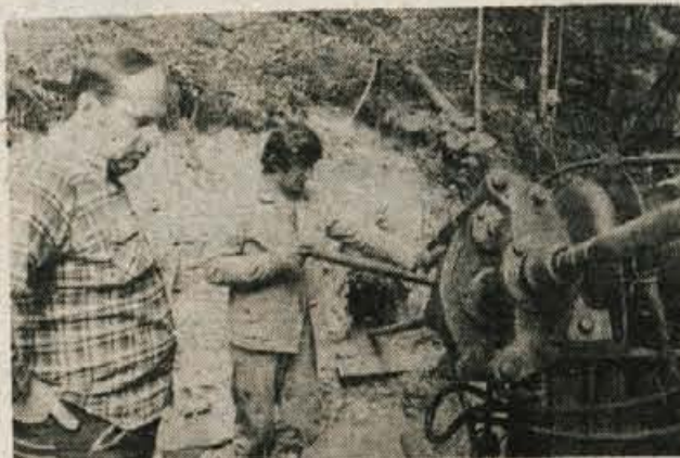
Iskanje vodnih zalog z globinskim vrtanjem je prvi poskus take vrste na Gorenjskem. Delavci se pri vrtini izmenjujejo v treh izmenah
