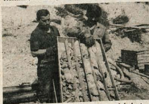
S prvo vrtino so zavrtali 153 metrov globoko ter sicer našli vodo, vendar pa so se odločili za drug poskus vrtanja nekaj metrov proč, kjer je voda pritekla že po dvajsetih metrih
