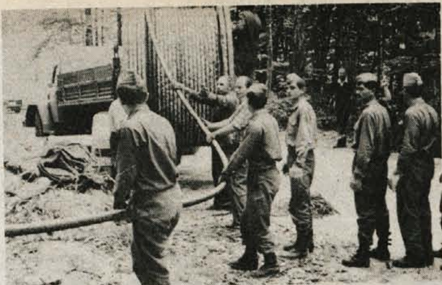
Na področju Turjaka polagajo vezisti iz enote Vujadina Mirkovića telefonski kabel skupaj z delavci Tegrada in pošte. — Foto: C. Z.
