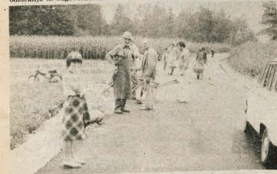
Blizu kilometer in pol asfalta je položenega med Lahovčami in Zalogom. Čisto nekaj drugega je to kot tisti večni prah, ki se je dvigal z makadama, in luknje, ki jih nisi nikoli sproti zasul. Z udarniškim delom bodo te dni krajanji Lahovč in Zaloga uredili še bankine in do krajevnega praznika v prvih dneh oktobra bo vse nared. — Foto: D. Dolenc
