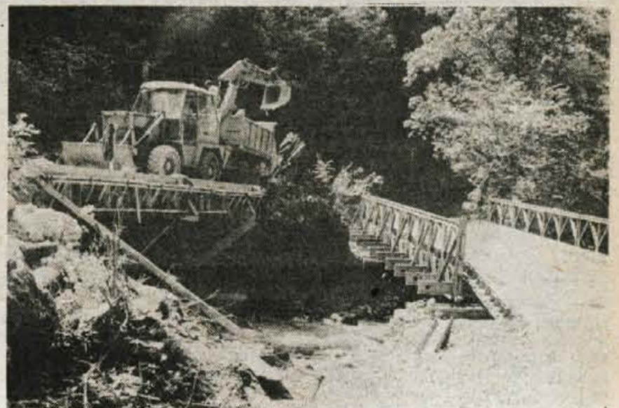
Most v Jelendolu dobi le še fini asfalt — Konec avgusta bi moral biti dokončan most čez Tržiško Bistrico, ki ga je gradil SGP Tržič. Pa so se deli zavlekli, a bo zdaj zdaj dokončan. Cestno podjetje je te dni čez most že položilo grobi asfalt, prihodnji teden pa še finega in most bo nared. — Foto: D. Dolenc
