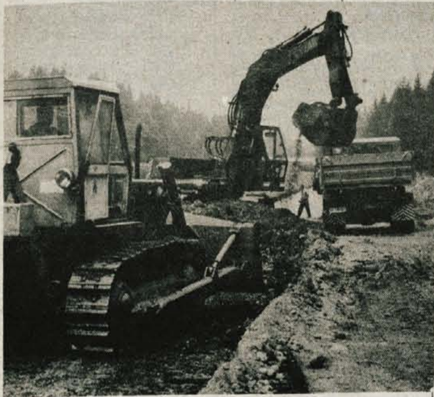
Rekonstrukcija ceste — Delavci Cestnega podjetja iz Kranja pospešeno gradijo 2 kilometra dolg odsek ceste Podreča—Kranj do Mavčič. Cesta bo velika pridobitev za krajane in za investitorja, Savske elektrarne. Računajo, da bo cesta nared do konca septembra, veljala pa bo 22 milijonov dolarjev. — Foto: -fr
