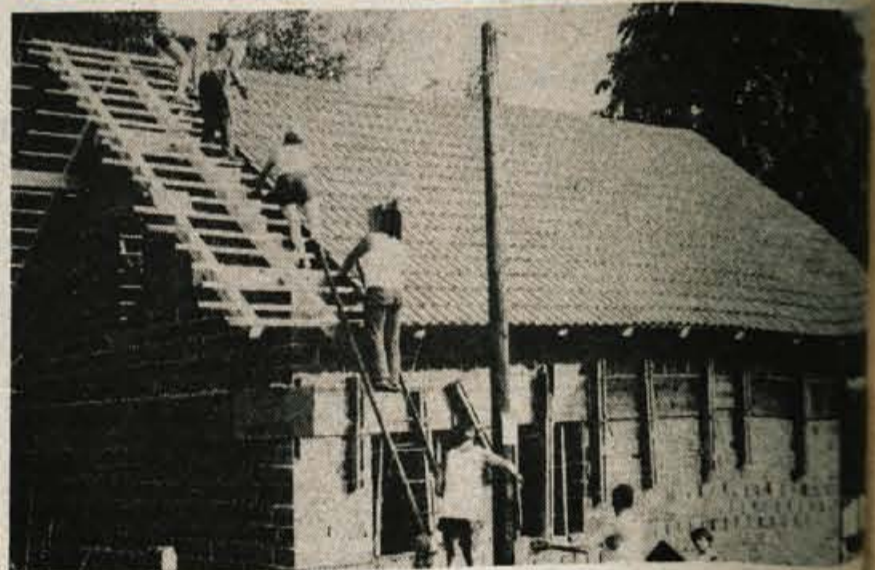
V Preddvoru gradijo – Preddvorčani so se vneto lotili gradnje nove turistične poslovalnice. Po dobrem mesecu je bila poslovalnica že pod streho. Pričakujejo, da bo do krajevnega praznika že nared. – P. L.
