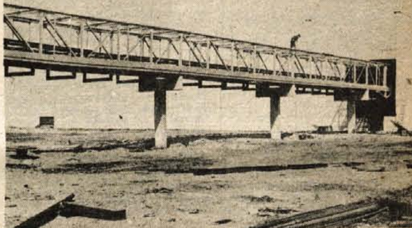
Nov transportni trak v Savi - Še tako urejen notranji prevoz izdelkov z viličarji in podobnimi obratnimi prevoznimi sredstvi je prepočasen, zavzame veliko proizvodnih površin, in če je še hitrejši, ovira proizvodnjo, so ugotavljali v kranjski Savi. Zato so se odločili za gradnjo veznega transportnega traku, ki bo pobiral vse vulkanizirane gume iz vulkanizacijske hale direktno od strojev, jih »peljal« čez cesto in odprt tovarniški prostor v »fnišo«, to je na očno in retingensko kontrolo ter naprej v skladišče. Tako bo ne le odpadel prevoz z viličarji in nalaganje težkih gum na vozčke, temveč se bodo izboljšale tudi delovne razmere pri vulkanizacijskih prešah; vroče gume, ki prihajajo iz preš in ostajajo zdaj pri strojih, bodo takoj odstranjene in zraku v proizvodnji bo veliko bolj čist in zdrav. Predvidevajo, da bo novi transportni trak stekel do konca polletja. - Foto: D. Dolenc
