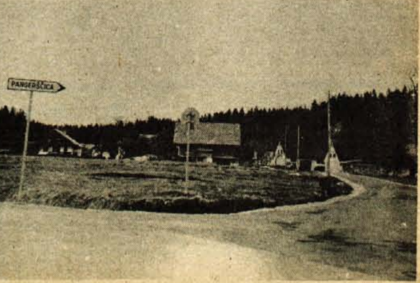
Cesta, ki so jo uredili in asfaltirali, je dolga 420 metrov
