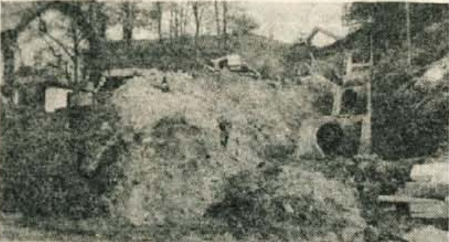
Kanalizacija - Gradbeno podjetje Gorenjc iz Radovljice s svojimi delavci in strokovnjaki dobro in hitro gradi kanalizacijo novega mesta Radovljice, saj se bojijo, da bi jih zima prehitela. Delo pa je precej težavno. - Foto: F. Debeljak
